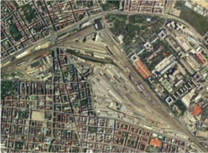
Abbildung: Bahnhof Wien - Europa Mitte als Beispiel für den Baustellentyp Hochbau Neubau sehr gross / Stadtteil
